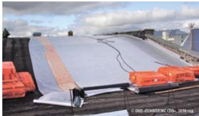
**Фото 2. Реконструкция старой битумной кровли с доутеплением. г. Нарьян-Мар**
