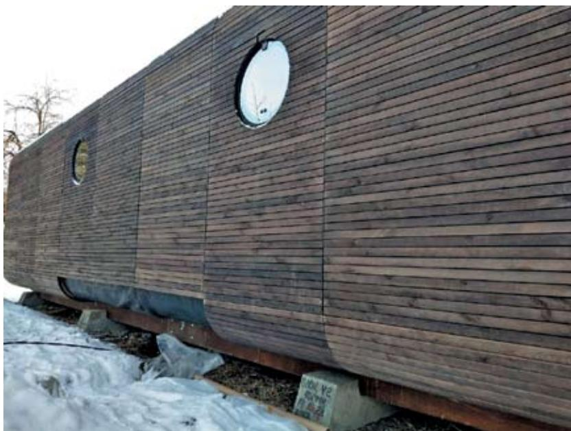
Рис. 2. Благодаря небольшому весу и жесткому каркасу для дома не требуется фундамент, достаточно гравийной подушки и бетонных «ребер», на которых фиксируются соединенные модули.
